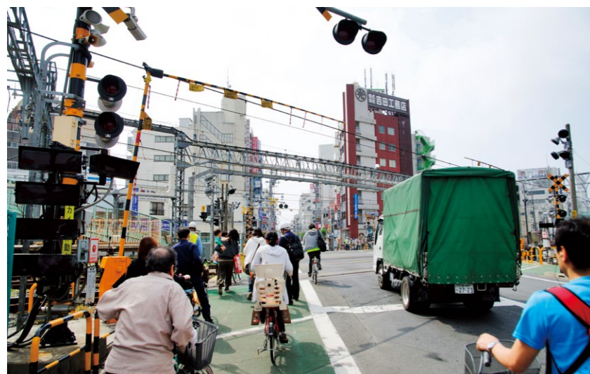
高架化工事前の竹ノ塚駅構内第37号踏切道
