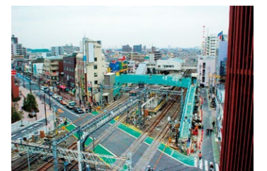
事故後には線路をまたぐ歩道橋を設置した
