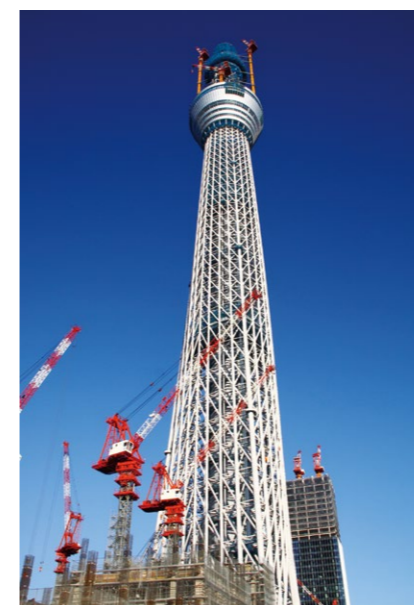
スカイツリー建設中の様子
