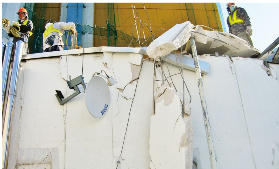
夷舟駅線路脇のビルの外壁が崩れ落ちた様子(左・中) (提供：東武谷内田建設)
