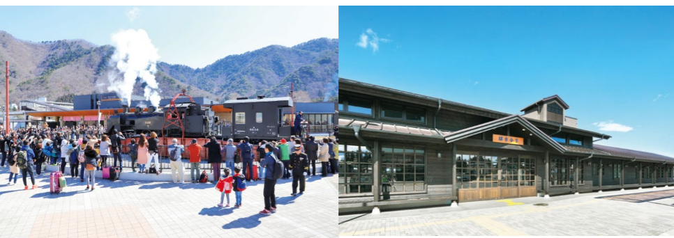
鬼怒川温泉駅に設置された転車台(左) 昭和レトロ風に改装された下今市駅(右)
