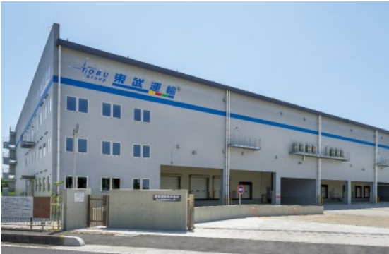
東武運輸の埼玉東物流センター支店1号棟倉庫。屋根には東武商事の太陽光発電所が設置されている（提供：2点とも東武運輸）
