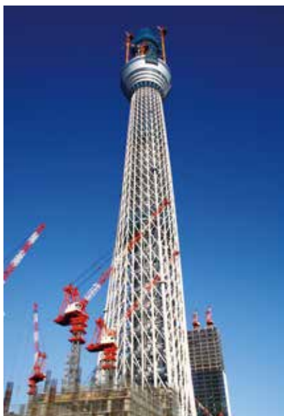
スカイツリー建設中の様子
