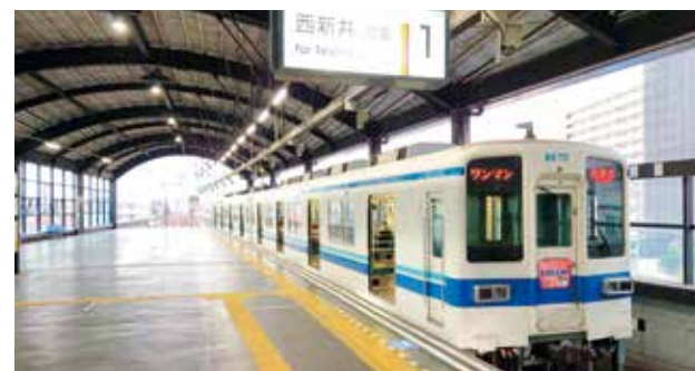
自動運転の検証を進めている大師線
