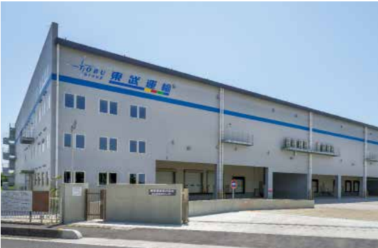
東武運輸の埼玉東物流センター支店1号棟倉庫。屋根には東武商事の太陽光発電所が設置されている (提供：2点とも東武運輸)
