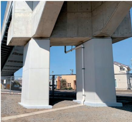
高架橋、長大橋梁、駅施設等で計画的に耐震補強工事を実施しています。
