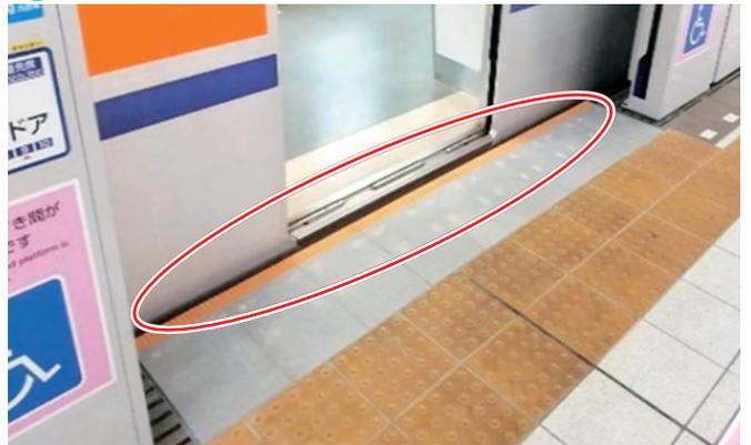
車イス等をお使いのお客様に、より安全にご利用いただけるよう、ホームの先端部を改修し、ホームと車両乗降口の段差・隙間を縮小しています。
