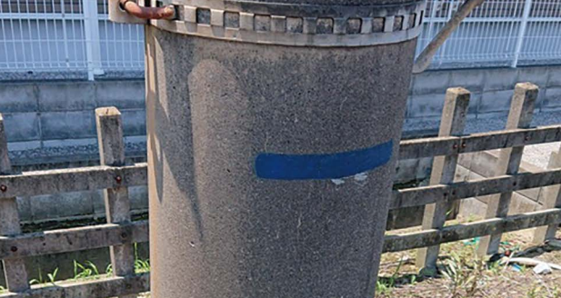
【浸水深マーキング（鷺宮～花崎間）】
