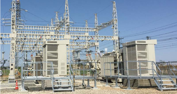
【基礎かさ上げ後】
