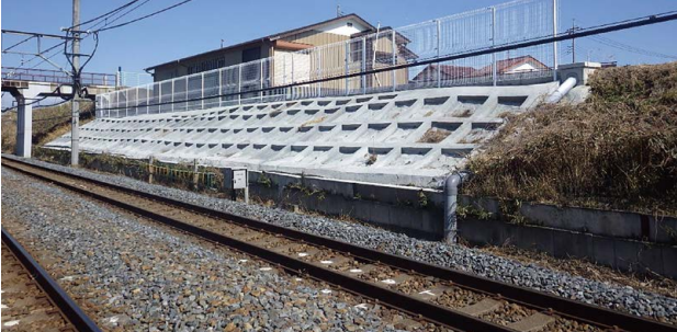
【法面改修（藤岡～静和間）】
