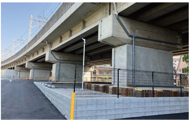
【高架橋耐震補強】
