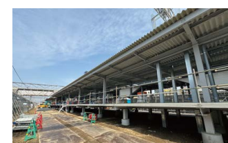
【春日部駅付近連続立体交差事業】
