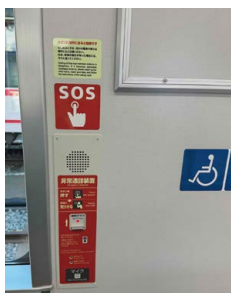
【非常通話装置】
