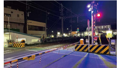
【踏切青色照明】
