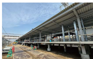
【春日部駅付近連続立体交差事業】
