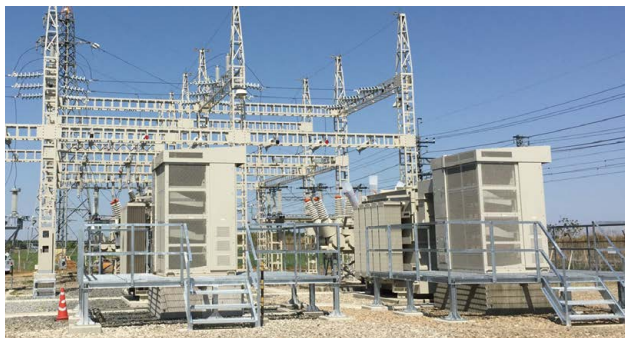
【基礎かさ上げ後】
