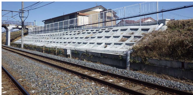
【法面改修（藤岡～静和間）】
