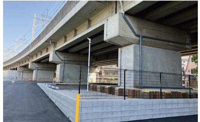
【高架橋耐震補強】
