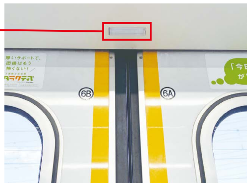
【扉開閉予告灯】
