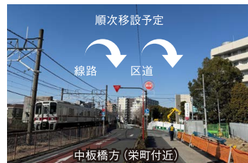
【区道と線路の移設工事】
