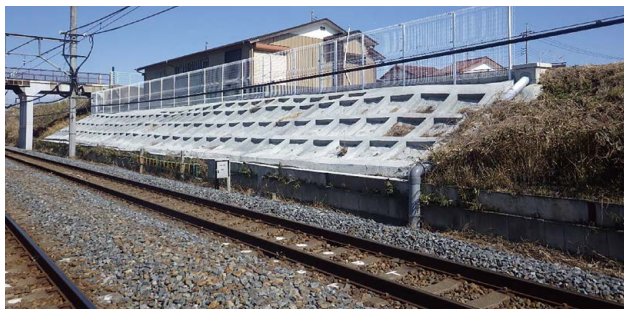
【法面改修（藤岡駅～静和駅間）】
