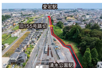
【付替え道路の整備】
