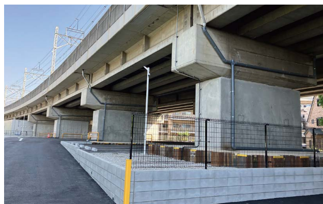
【高架橋耐震補強】
