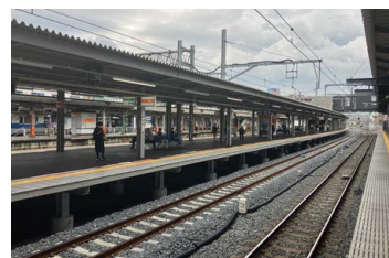
【伊勢崎線仮下り線および仮下りホーム】
