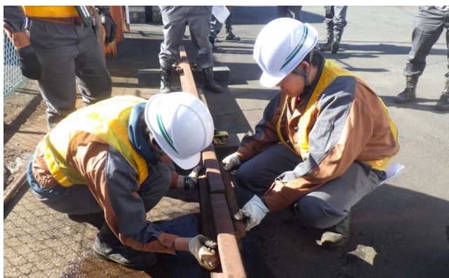
【レール折損時における応急復旧訓練】
