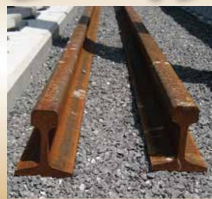
レールとは、列車の走行路であるとともに、列車が進む方向を決める案内路であり、左の写真にある鋼製のレール2本を平行に並べて使用します。レール1本当たりの標準長さは25m(これを定尺(ていじやく)レールといいます)であり、これをつなぎ合わせていきます。鉄でできているレールは温度により伸び縮みするため、継目(つぎめ)には隙間を設けてそれを吸収するようにしています。しかし継目はどうしても騒音・振動の発生源となってしまうことから、継目を溶接する方法が考え出されました。1本の長さが200m以上になるものを**ロングレール**と呼び、騒音・振動を低減し、列車の乗り心地を向上できるため、新しい下り急行線にも採用しています。ロングレールは定尺レールに比べ、温度による伸び縮み量が大きいため、始終端部には伸縮継目(しんしゅくつぎめ)と呼ばれる継目が使われています。
