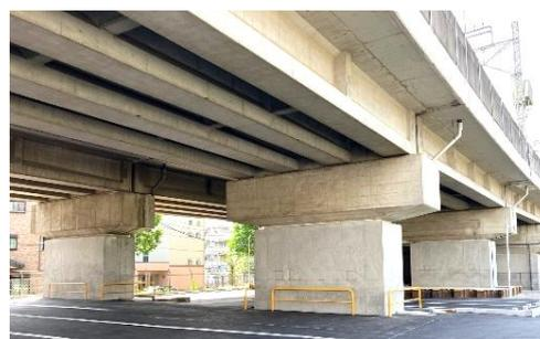
△ 高架橋柱等耐震補強の状況 (小菅～五反野駅間)
