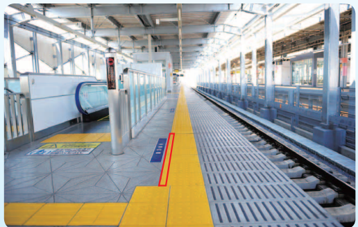
3 内方線付き点状ブロック
