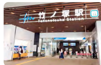
竹ノ塚駅改札口天井照明
