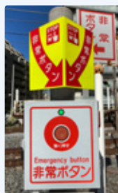
踏切支障報知装置（押ボタン式）
