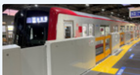
ホーム柵（可動式）越谷駅
