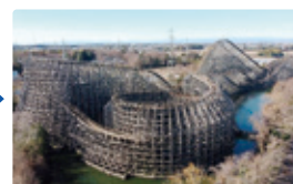
電力を供給される東武動物公園
