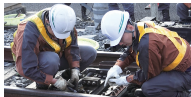
転てつ器を点検する様子
