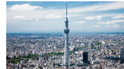
2012年 東京スカイツリータウン®オープン
