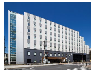
東京曳舟病院
