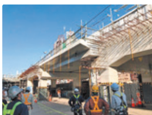
施工場所等の安全巡視・確認状況
