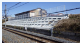
法面改修（藤岡～静和間）
